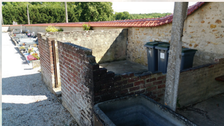
Local poubelle au cimetière avant travaux
