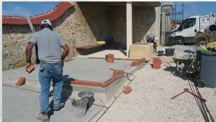
Local poubelle au cimetière avant travaux
