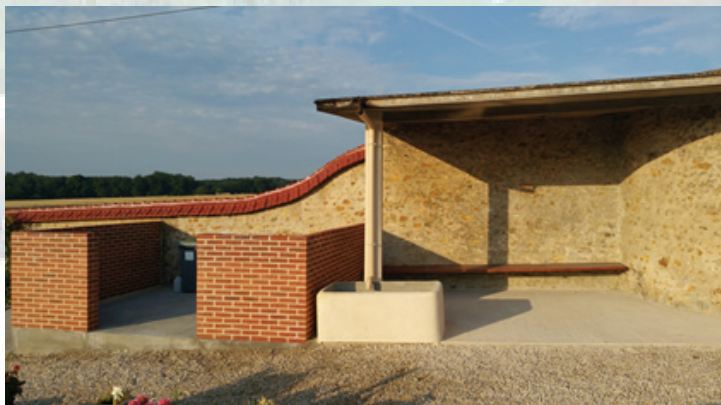
Local poubelle après travaux
