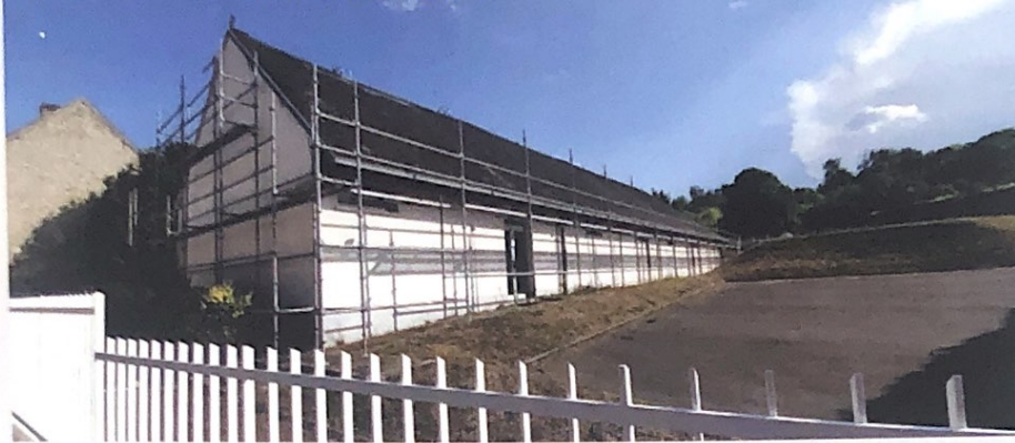
Ecole primaire – l'échafaudage avant travaux
